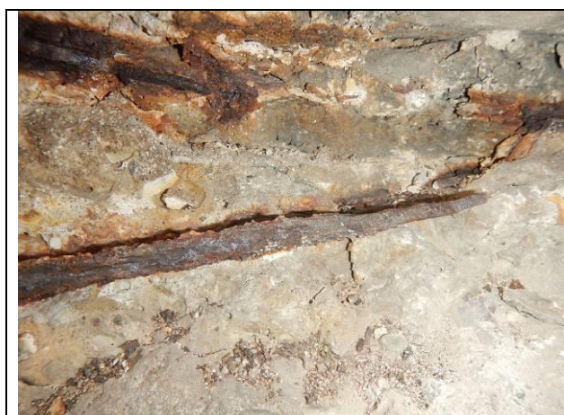
Figure 4 : Sondage de reconnaissance sur armatures en partie courante d'une cloison
