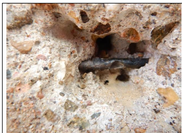
Figure 8 : Sondage de connexion sur armature État des aciers : sains
