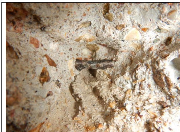
Figure 6 : Sondage de connexion sur armature État des aciers : corrosion par piqûres sans perte de section
